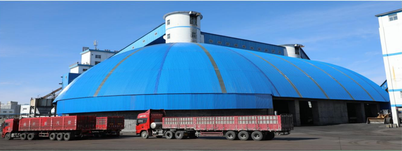
陕北矿业公司韩家湾煤矿封闭式储煤棚
