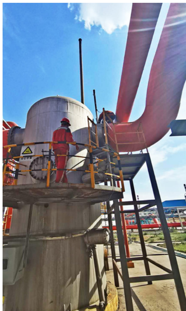
2020年5月，甲醇一厂合成车间高效完成压缩机检修，各分离器、水冷器的清理，密封气改造等检修任务一期检修工作
