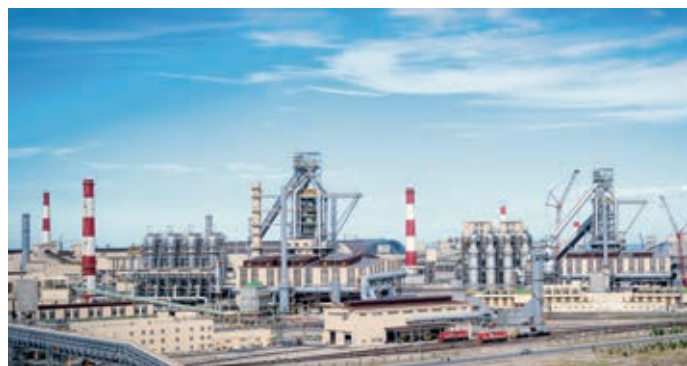
越南台塑河静钢铁项目
