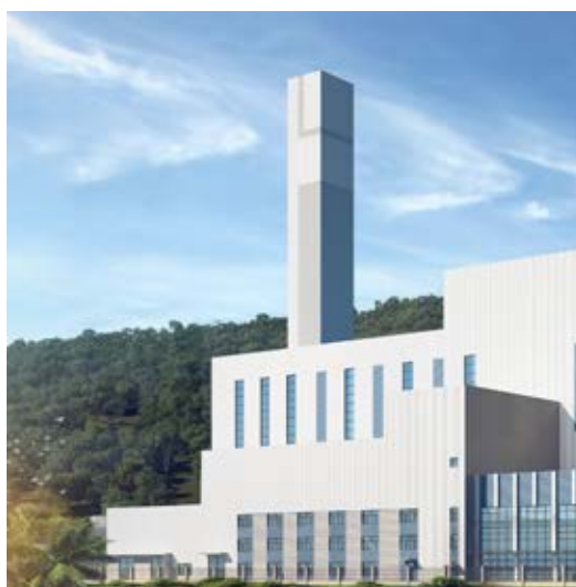
厦门垃圾焚烧发电厂项目
