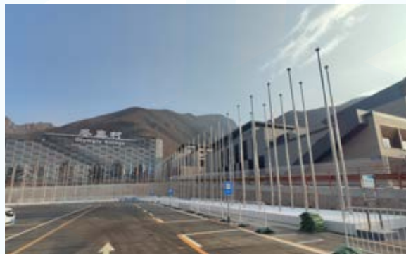
延庆赛区临时设施项目
