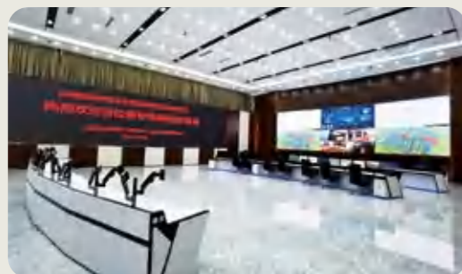
3800m 3 高炉集控中心
