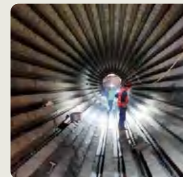
120 万吨球团回转窑耐材节能改造
